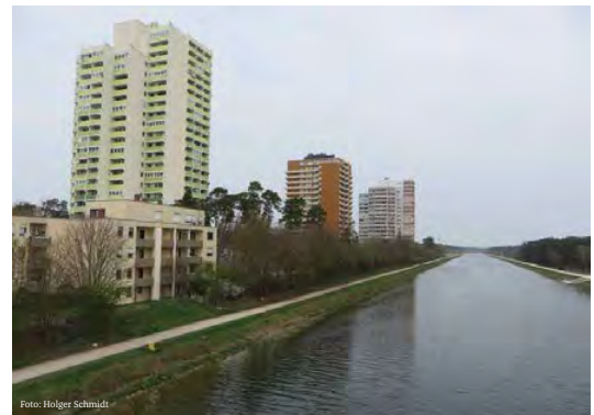
Foto: Holger Schmidt Hochhäuser am Kanal (WEG)
