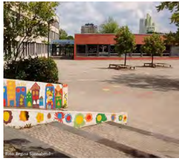
Mönaschule: Aula und Schulhof
