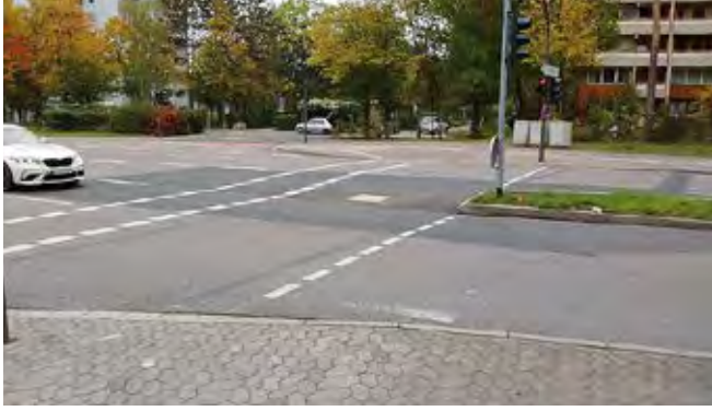
Barrierefreier Umbau Mittelinsel Straße Am Europakanal (2020)
