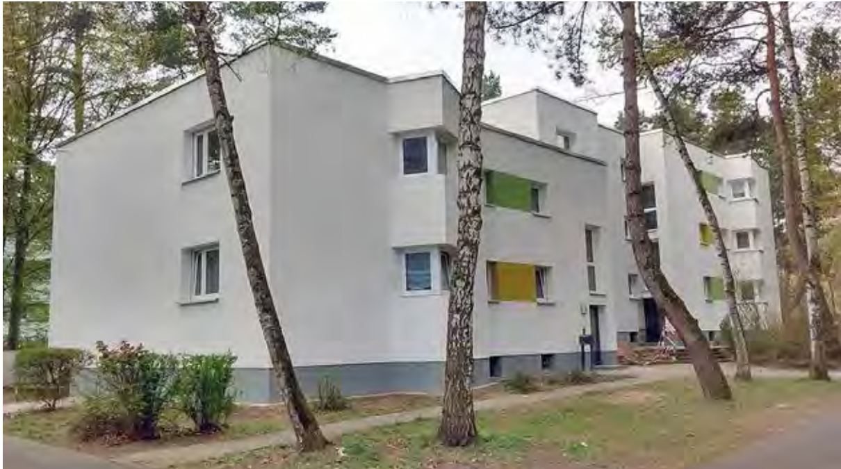
Saniertes Wohnungsbestand der GEWOBAU an der Schweinfurter Straße
