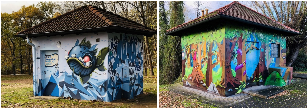
Abbildung 16: Außengestaltung Pumpstationen Ebrardstraße und Bayernstraße
