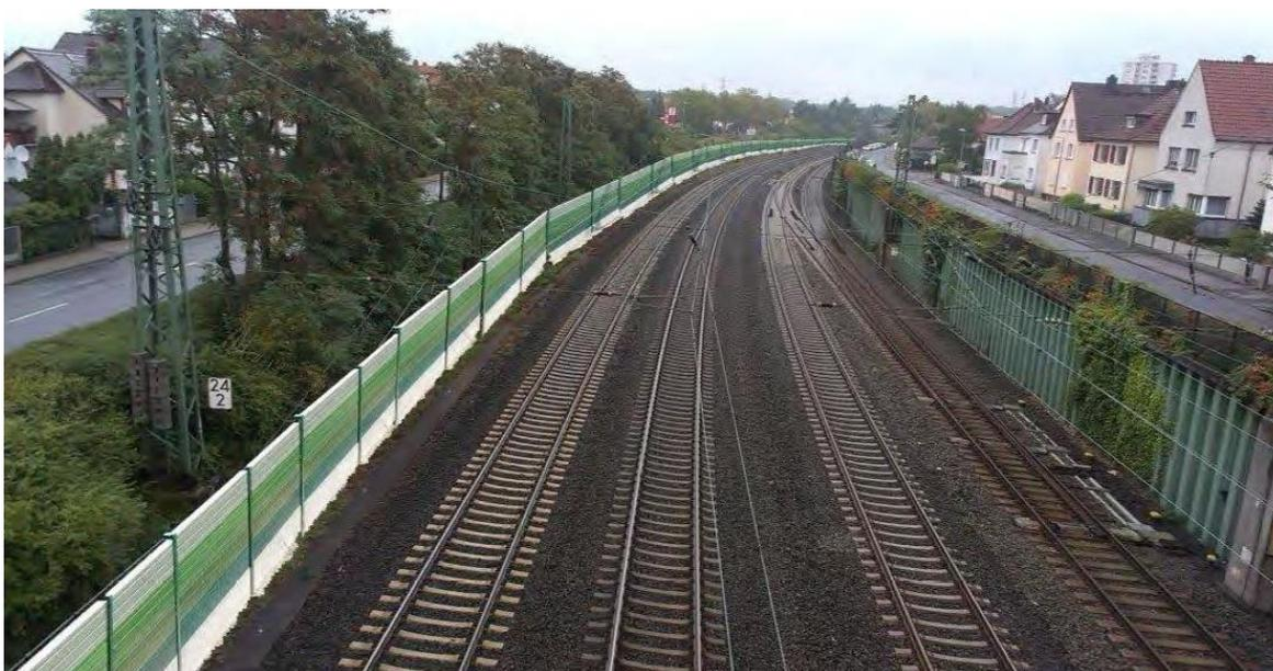
Foto: Beispiel für Lärmschutz entlang einer Haupteisenbahnstrecke
