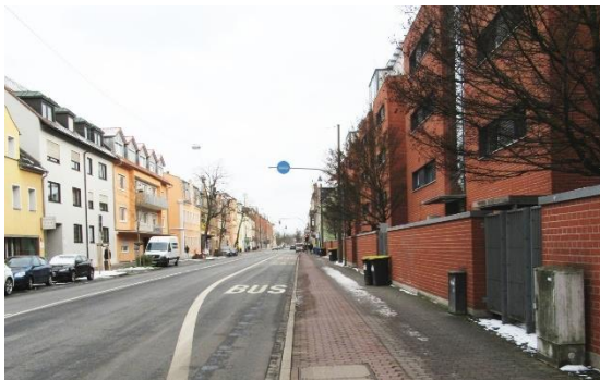
Foto: Haltestelle Hartmannstraße, ehemals Großpflaster, Sanierung 2022 erfolgt
