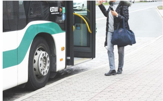
Foto: Haltestelle Berufsschulzentrum, im Zuge des Belagsaustauschs sollte die Herstellung der Barrierefreiheit (Bordhöhe, taktile Elemente) in Betracht gezogen werden
