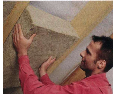
Vollsparrendämmung
