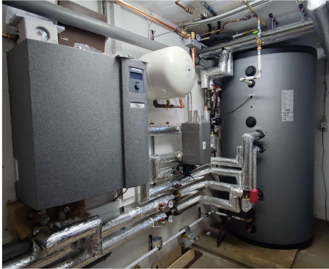
Steuerung und Pufferspeicher (830 l)
