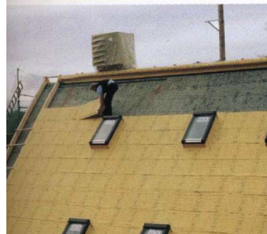
Aufsparrendämmung
