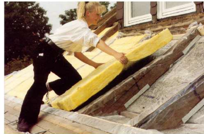
Die feuchteadaptive Dampfbremse wird zwischen die Sparrenfelder verlegt.
